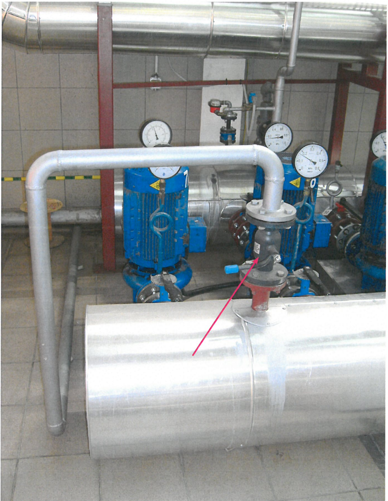
Włączenie rurociągu „wysysającego” zimną wodę z kotłów
